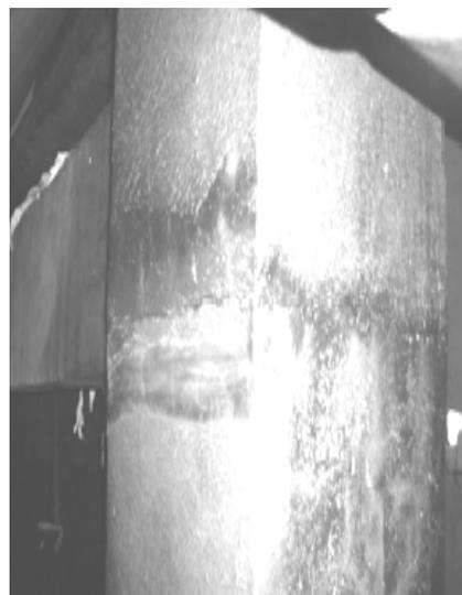
**Рис. 1 - Трещина в колонне КМ-9 с приводной стороны третьей сушильной группы БДМ**
