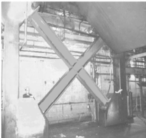
**Рис. 2 - Усиление фундамента сушильной части БДМ**
